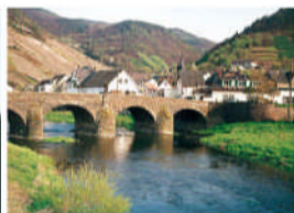
Bild 13: Ahrbrücke bei Rech
